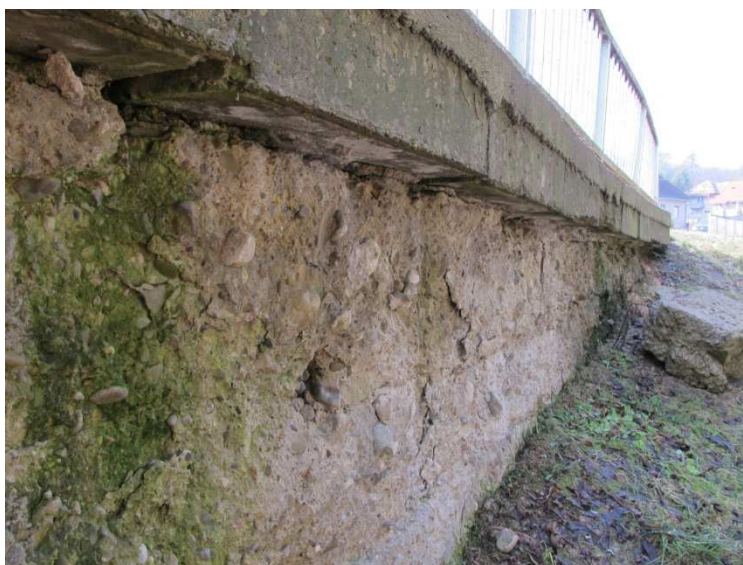
Obr. 3 - Pohľad na krídlo opory. Degradácia betónu na pohľadových plochách vplyvom vlhkosti. Betón zdegradovaný, vypadaný a napadnutý vplyvom vodnej erózie.
