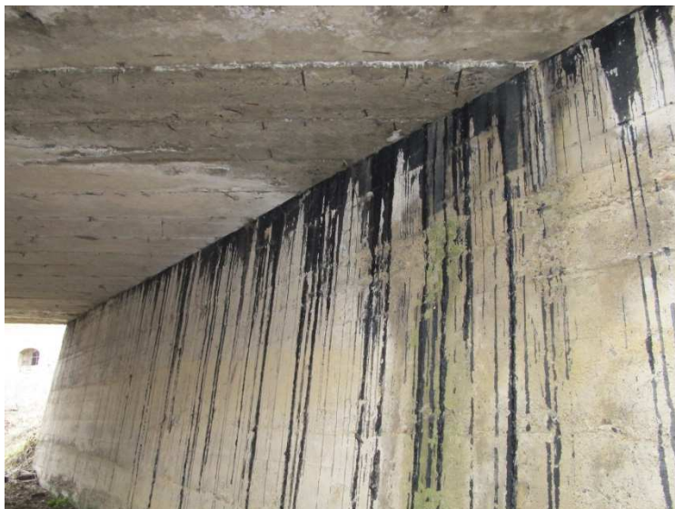
Obr. 2 - Pohľad na strop nosnej konštrukcie. Degradácia betónu vplyvom vlhkosti, výluhy na betóne, korózia výstuže.
