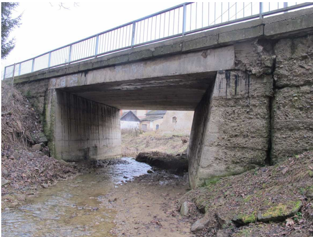
Obr. 1 - Pohľad na mostný objekt. Degradácia betónu spodnej stavby, narušenie a erózia brehov koryta, výluhy na nosnej konštrukcii.
